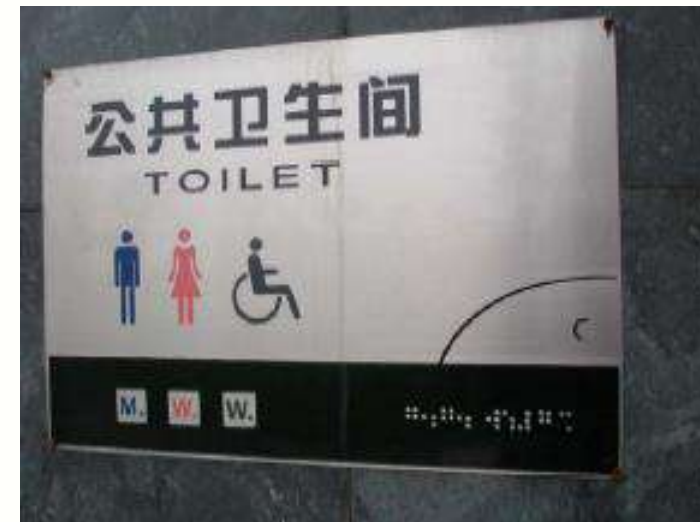
Дублирование указателей для лиц с различной степенью инвалидности по зрению (световые, звуковые индикаторы и знаки в технике Брайля)
