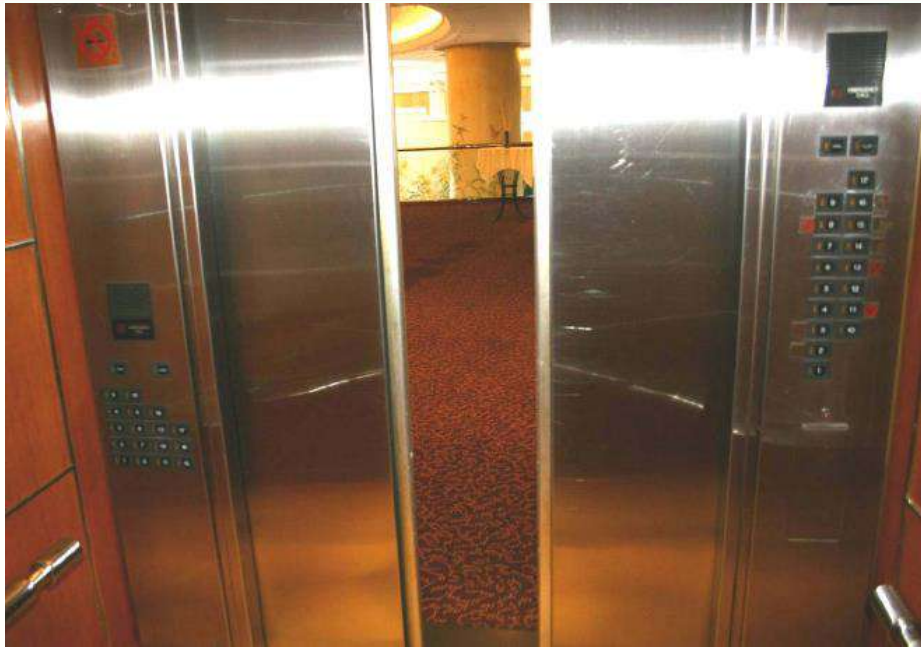
Дублирование панели управления кабиной лифта на двух уровнях
