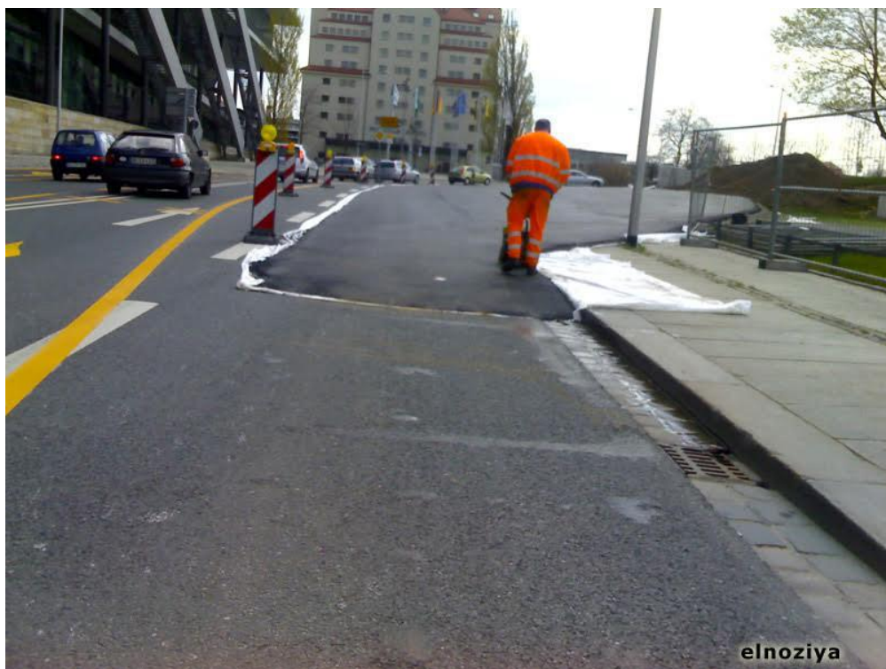
Рисунок 55: Временная смена покрытия
